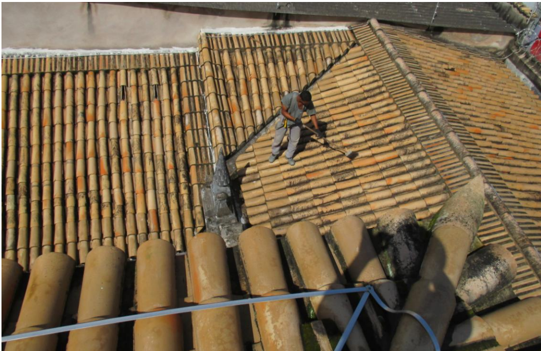
Foto 02: Pintura dos tubos de descida de águas pluviais do telhado da igreja.
