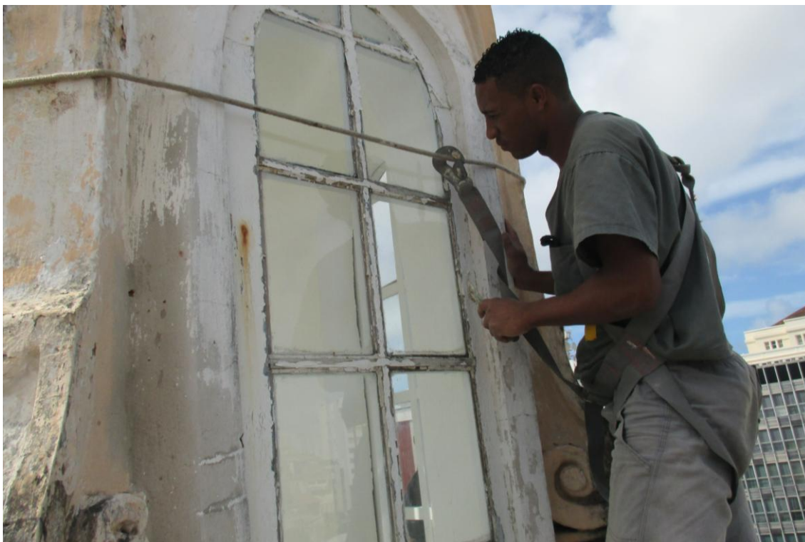
Foto 03: Aplicação de silicone nas janelas do lanternim da cúpula da igreja.
