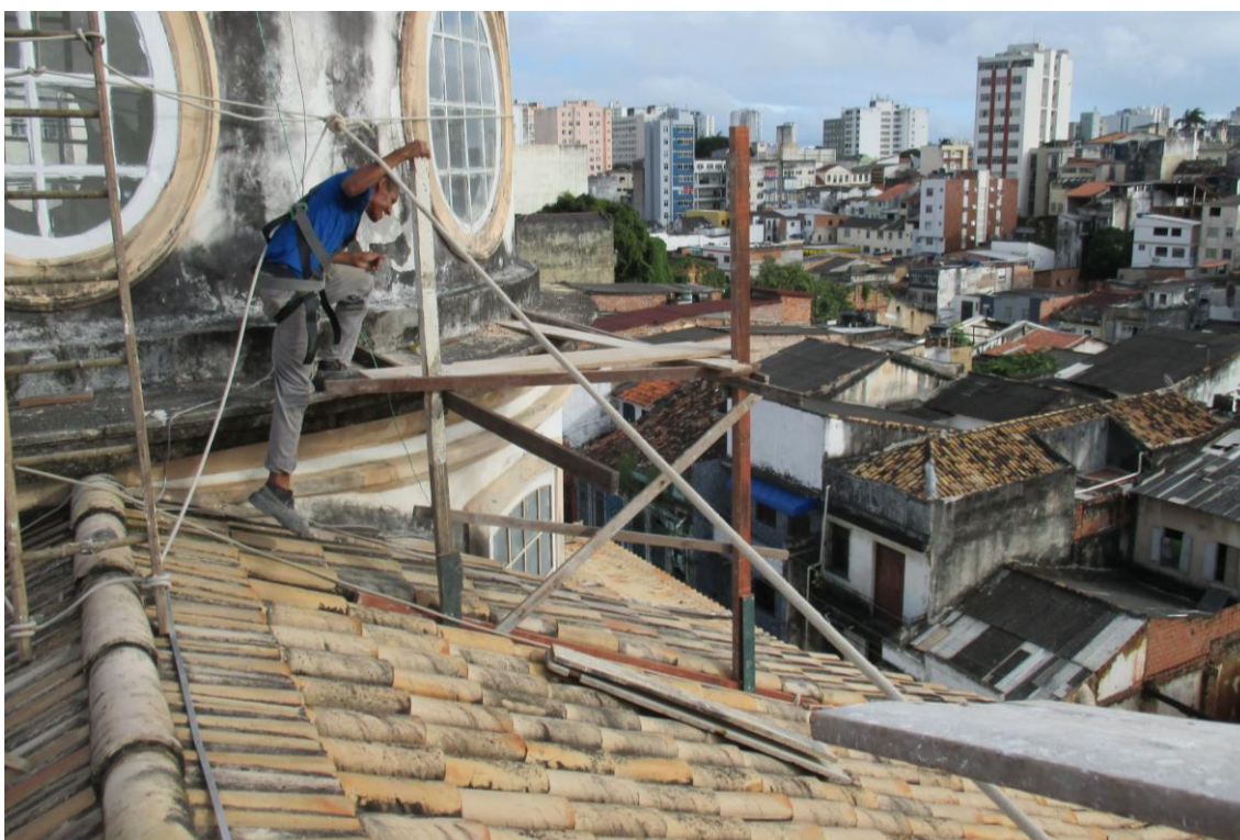
Foto 04: Montagem de andaime para recomposição de reboco e tratamento das fissuras na cúpula da igreja.
