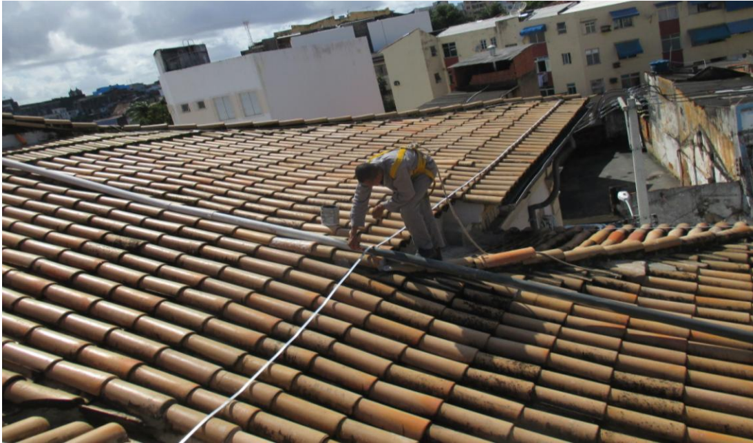
Foto 01: Pintura dos tubos de descida de águas pluviais do telhado da igreja.
