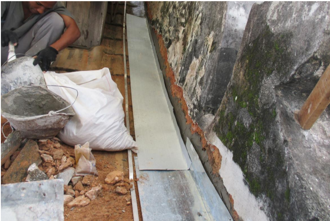
Foto 01: Confeção de rufo no telhado da nave da igreja.
