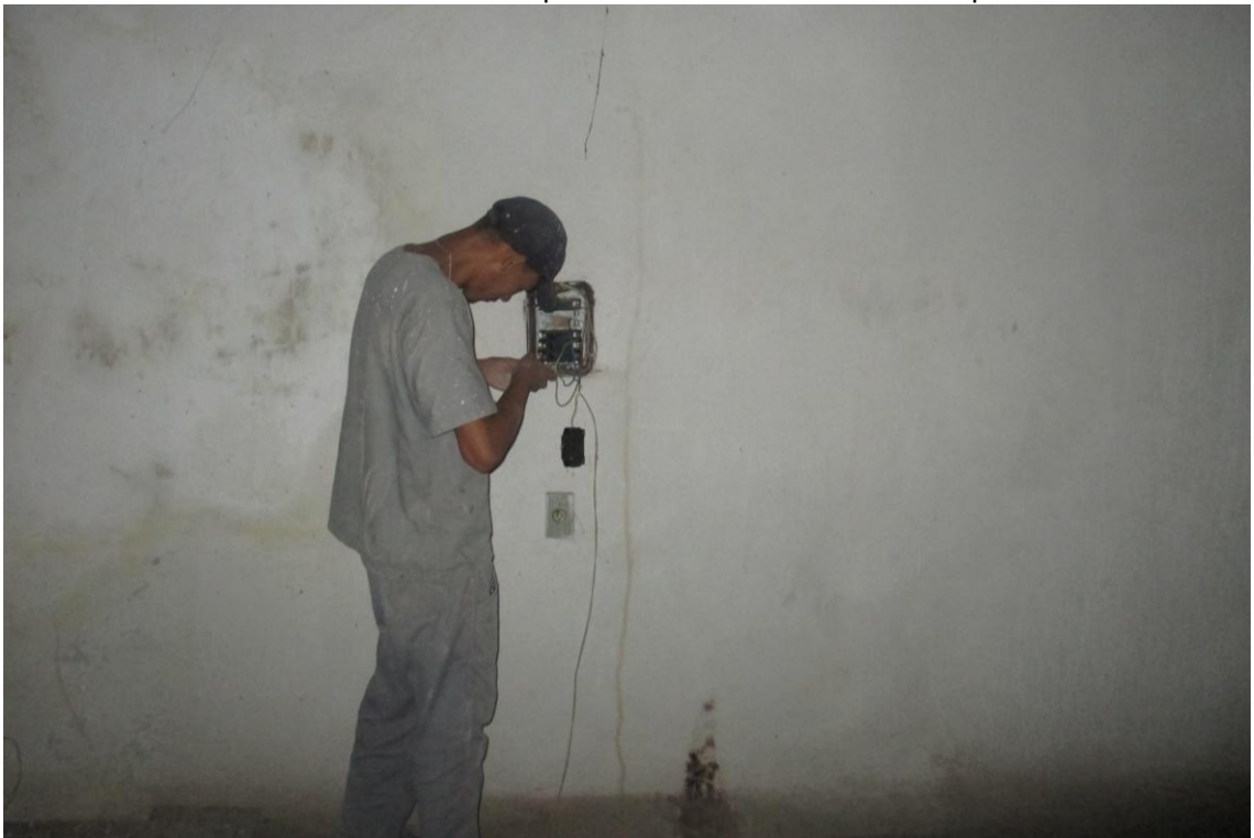
Foto 03: Passagem da fiação para instalações elétricas da igreja.
