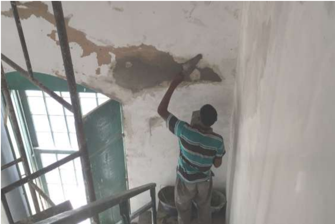
Foto 06: Acabamentos nas paredes internas da torre sineira direita.
