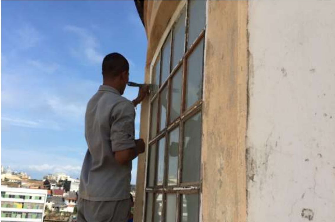
Foto 04: Restauração das esquadrias da cúpula da igreja.
