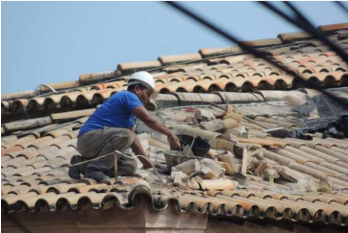
Foto 01: Reparos no telhado da igreja.
