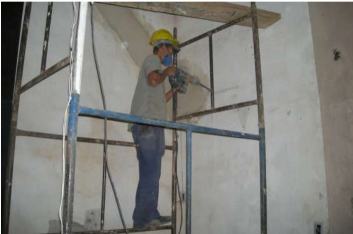
Foto 03: Continuação dos cortes nas paredes do presbitério e passagem de tubulação para instalação elétrica e sonorização.
