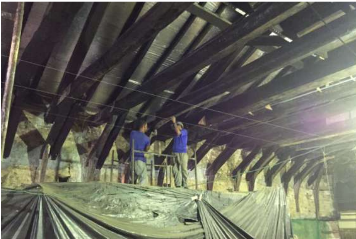
Foto 03: Restauração e confecção de peças das cambotas da estrutura portante do forro artístico da nave.
