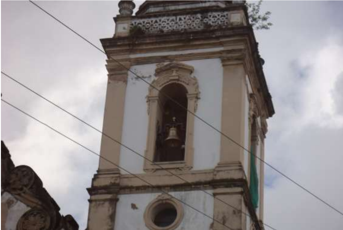
Foto 06: Sino grande, voltado para a ladeira de Santana, instalado e automatizado.
