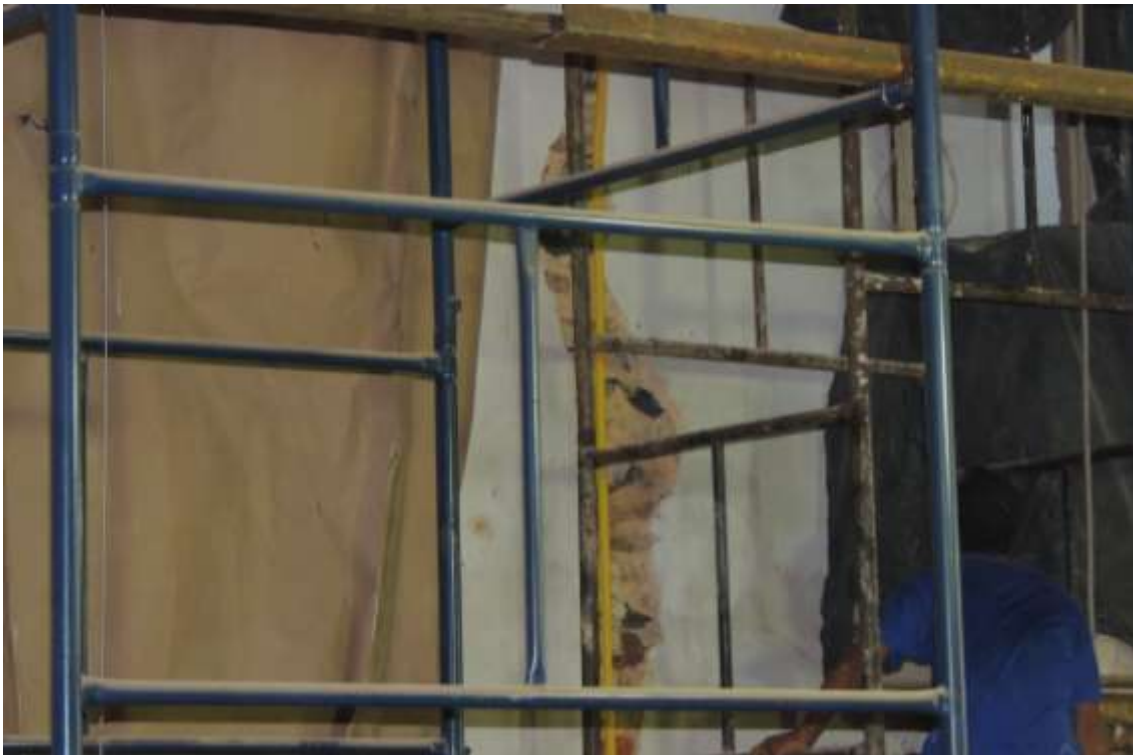
Foto 01: Continuação dos cortes nas paredes da nave e passagem de tubulação para instalação elétrica e sonorização.
