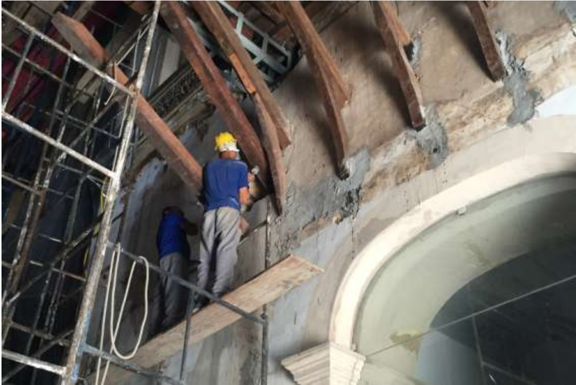
Foto 04: Restauração e confecção de novas peças das cambotas de mão francesa da estrutura portante do forro artístico do baixo coro da igreja.
