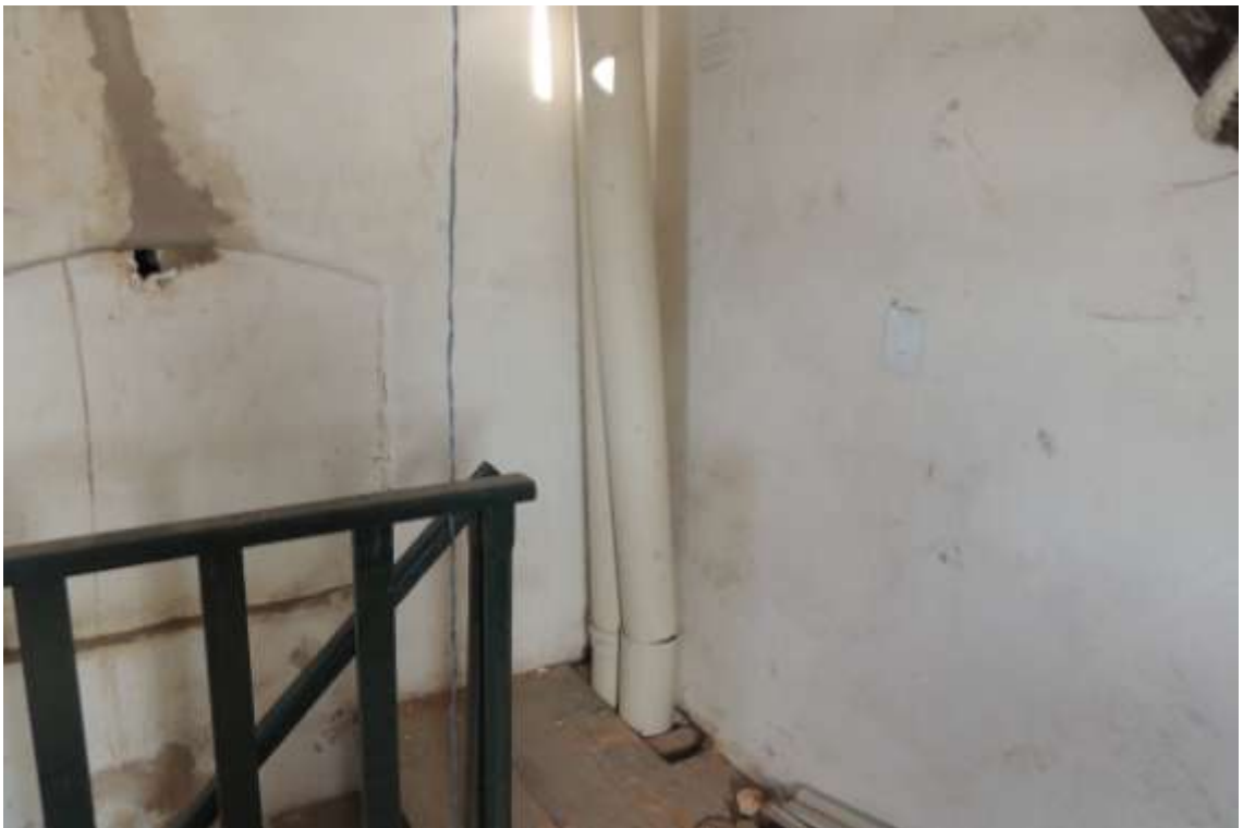
Foto 05: Tubulação para exaustão das condensadoras de ar condicionado no depósito da torre sineira esquerda.
