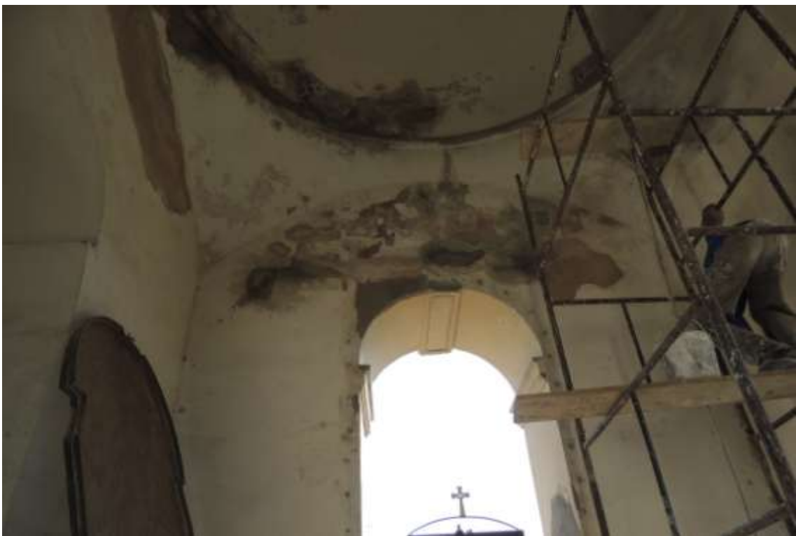
Foto 09: Acabamentos e pintura, a base de cal, nas paredes internas da torre sineira esquerda.
