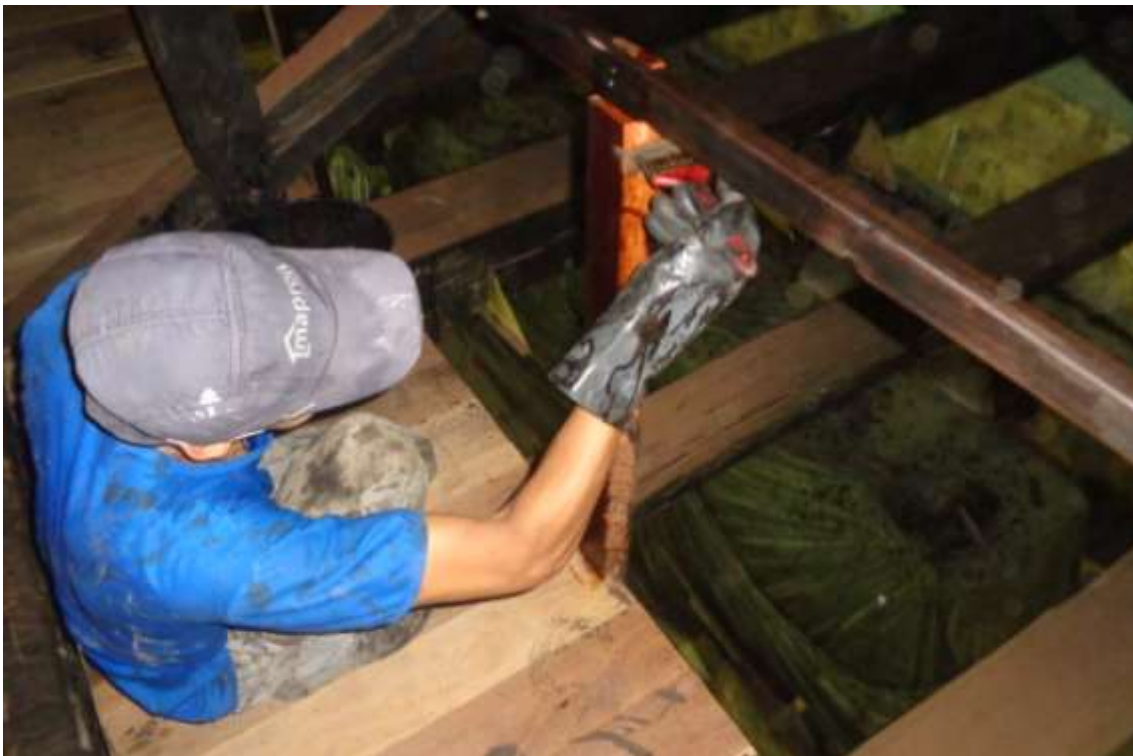
Foto 07: Imunização do corrimão da passarela do telhado da nave.
