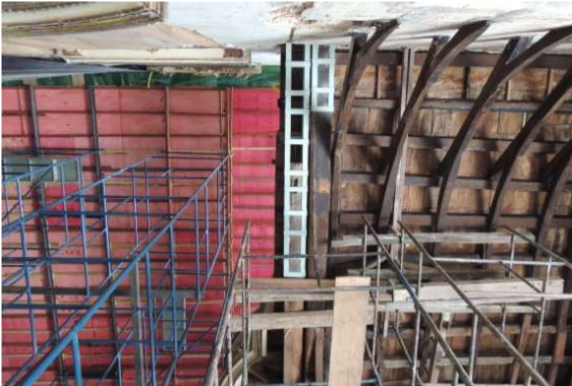
Foto 04: Confeção de emendas metálicas nas cabeceiras das peças madre da estrutura do coro da igreja.
