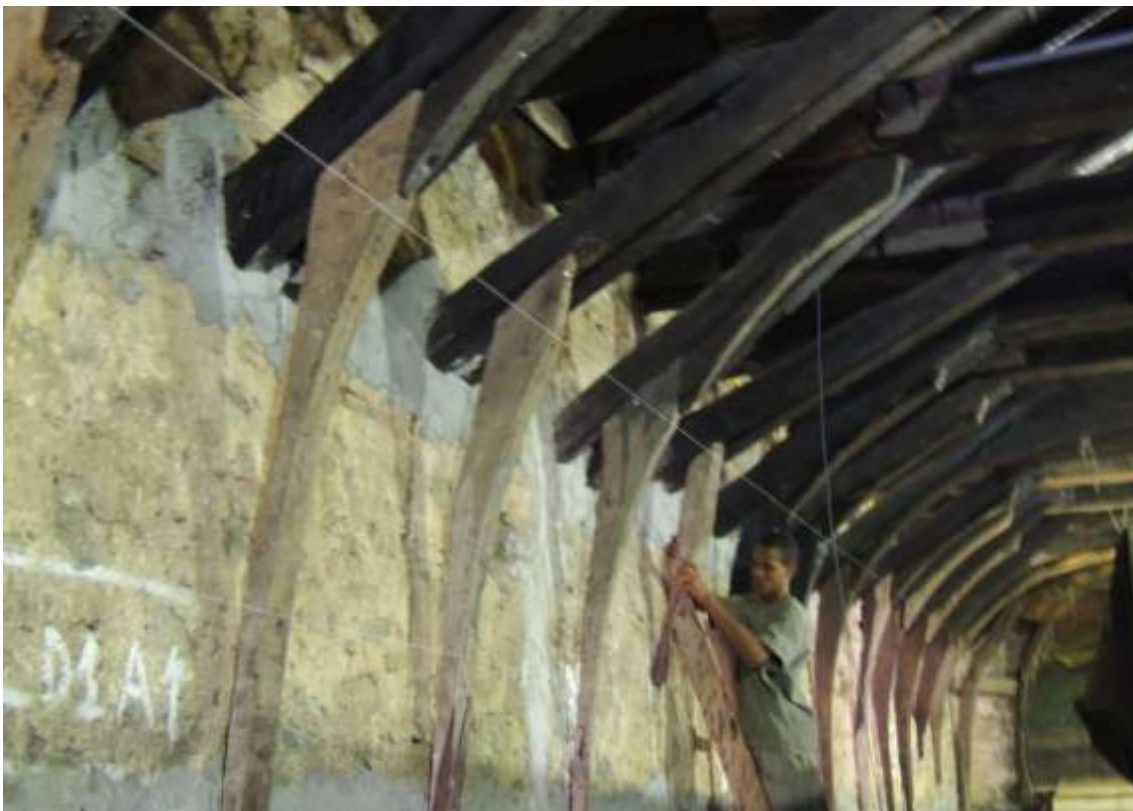
Foto 03: Restauração e confecção de peças das cambotas da estrutura portante do forro artístico da nave.
