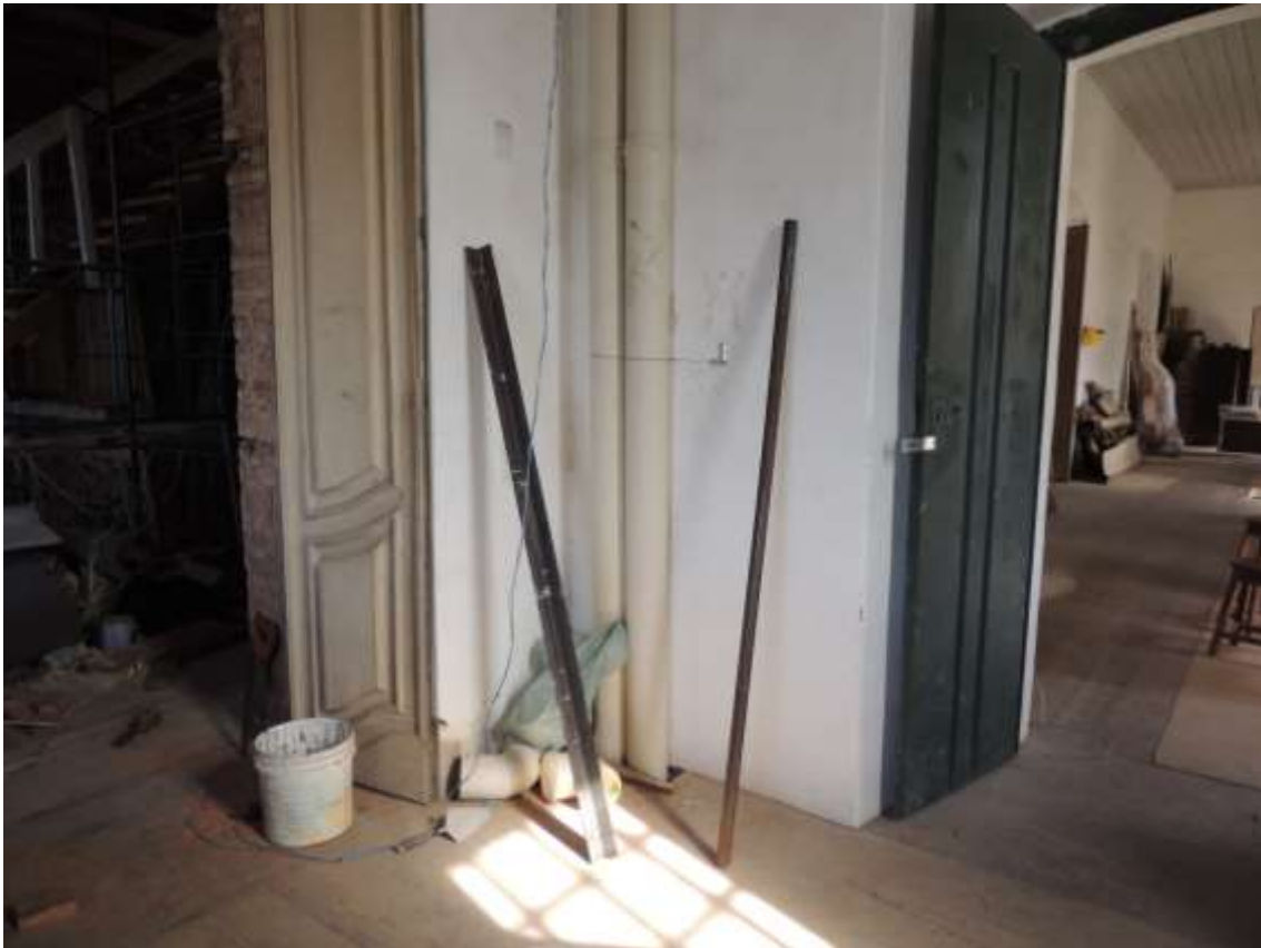
Foto 08: Tubulação para exaustão das condensadoras de ar condicionado no depósito da torre sineira esquerda.
