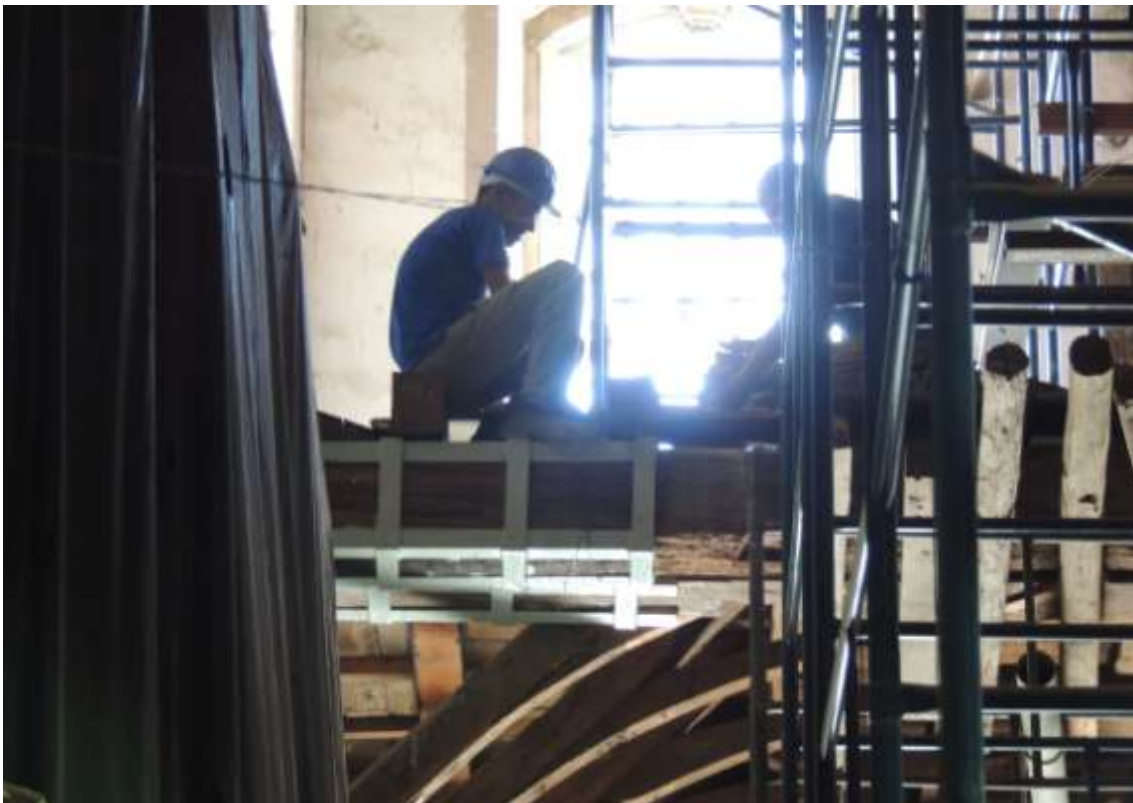
Foto 05: Confeção de emendas metálicas nas cabeceiras das peças madre da estrutura do coro da igreja.
