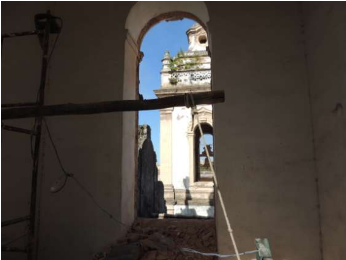
Foto 10: Abertura de vão na torre sineira esquerda para instalação do sino.
