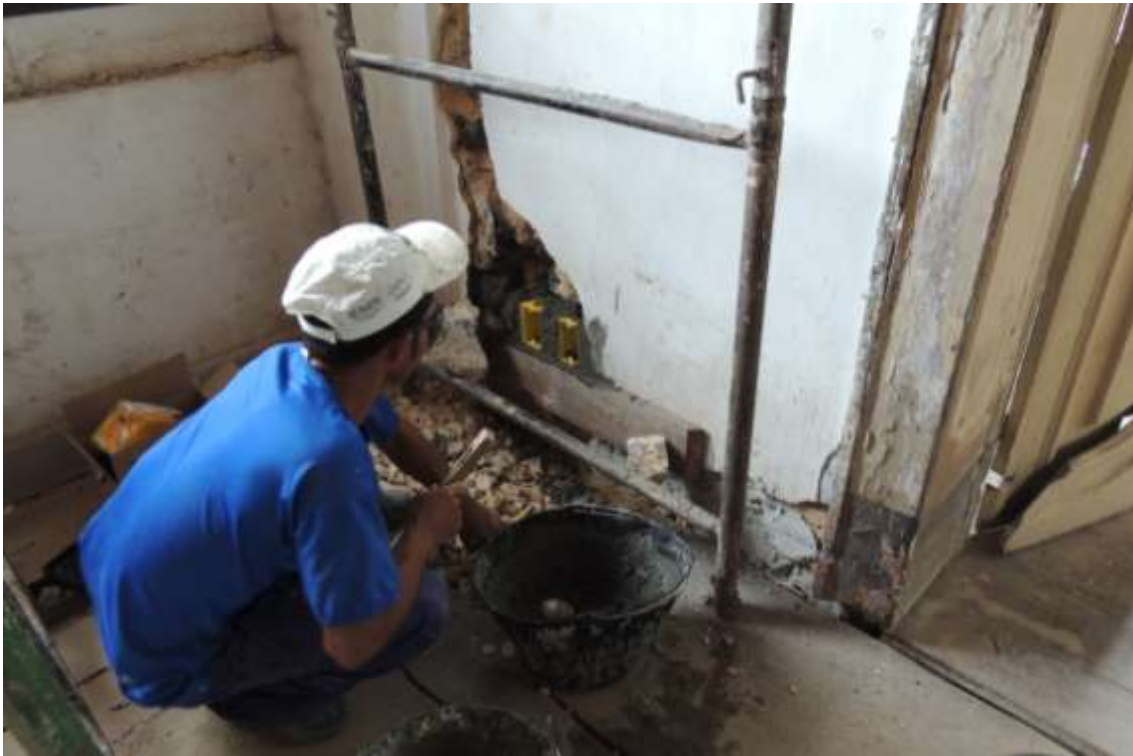
Foto 02: Passagem e chumbamento da tubulação e caixas de passagem para instalação elétrica e sonorização nas paredes da nave.
