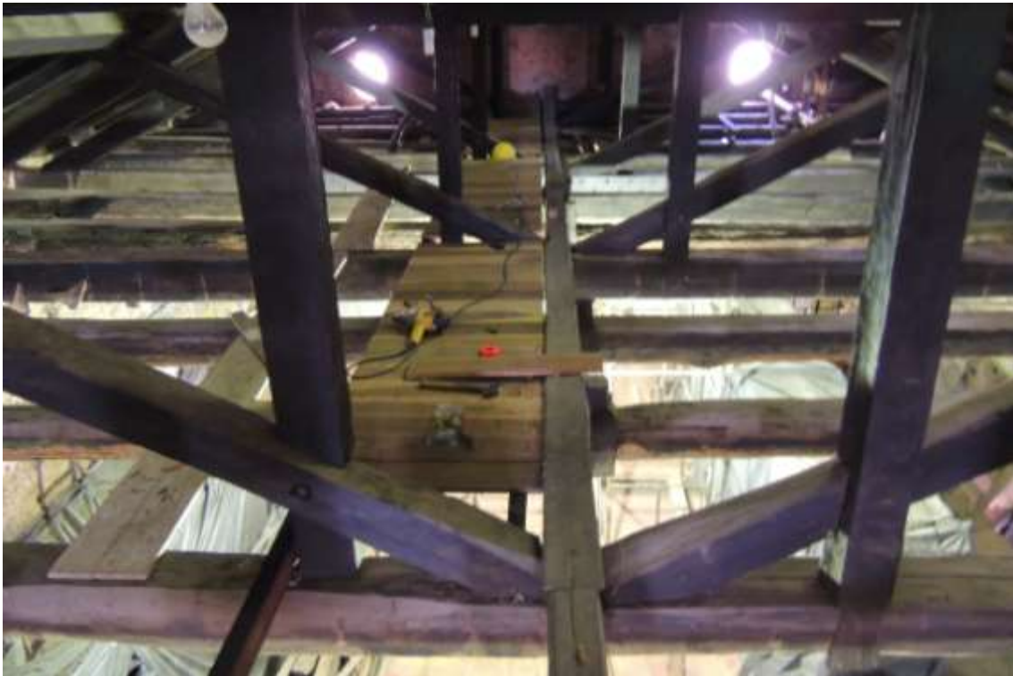
Foto 06: Passarela e corrimão de madeira no telhado da nave da igreja.
